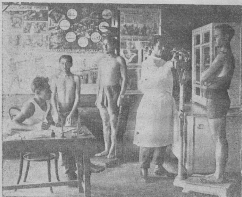
Кабинет врачебного контроля дома отдыха «Березовка».
